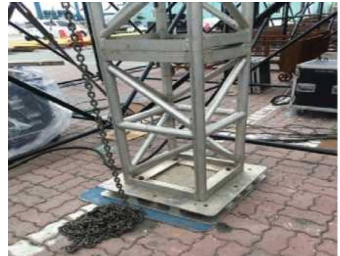
구조물 전도방지를 위한 아웃트리거 미설치 (설치 상태 미흡)
