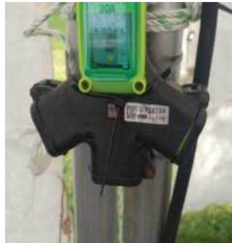
외부에 노출되는 콘센트 설치 시 방수형 콘센트 사용 (양호)
