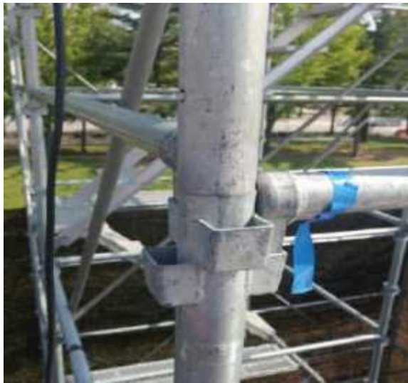
비계 구조물 체결 상태 양호(포켓 형)
