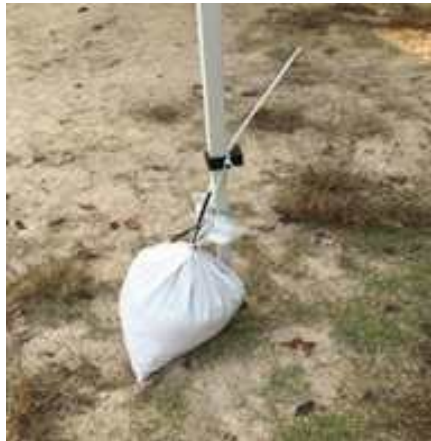
텐트 전도방지 조치 양호 (모래주머니 사용)
