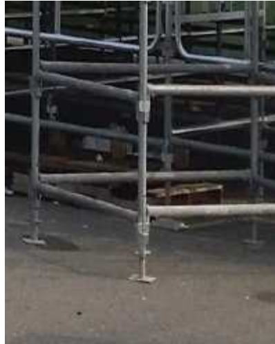
콘크리트 또는 아스팔트 위에 설치 (지반상태 양호 )
