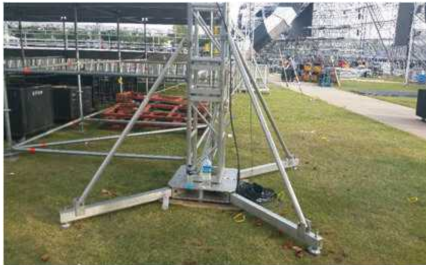
구조물 전도방지를 위한 아웃트리거 설치 (설치 상태 양호)
