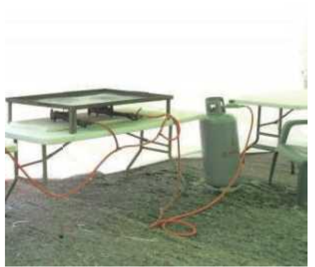
가스용기와 화기시설 안전거리 미 확보(미흡)
