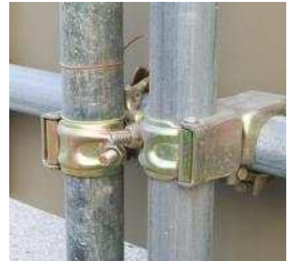
비계 구조물 체결 상태 양호(클램프)
