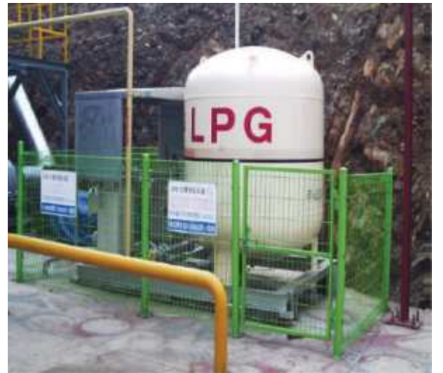
가스용기와 화기시설 안전거리 확보 및 접근 통제(양호)
