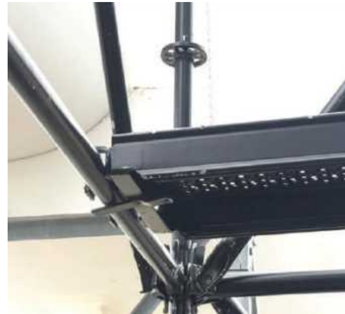
작업발판 이탈방지조치 설치(설치 상태 양호)
