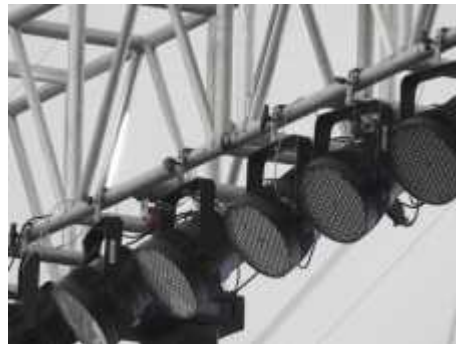
조명기 안전고리 설치(양호)
