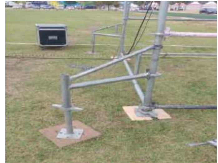
구조물 전도방지를 위한 아웃트리거 및 깔판 설치 (설치 상태 양호)
