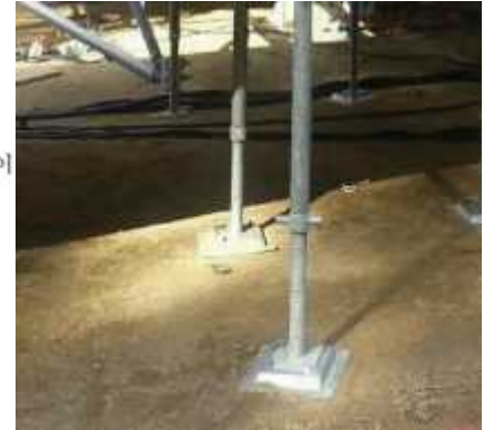
조절형 받침철물 구성 및 설치 사례
