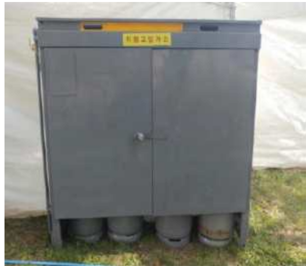
가스용기 보관함 잠금장치 사용(양호)
