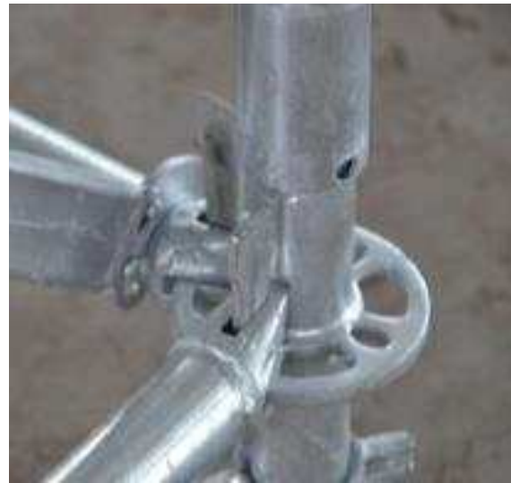
비계 구조물 체결 상태 양호(연결핀 형)
